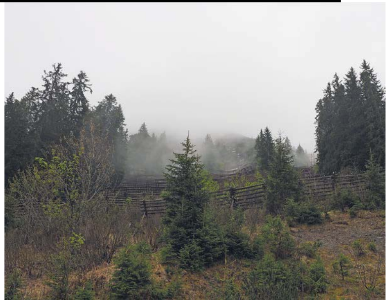
Stahlverbauungen im oberen Hangbereich
